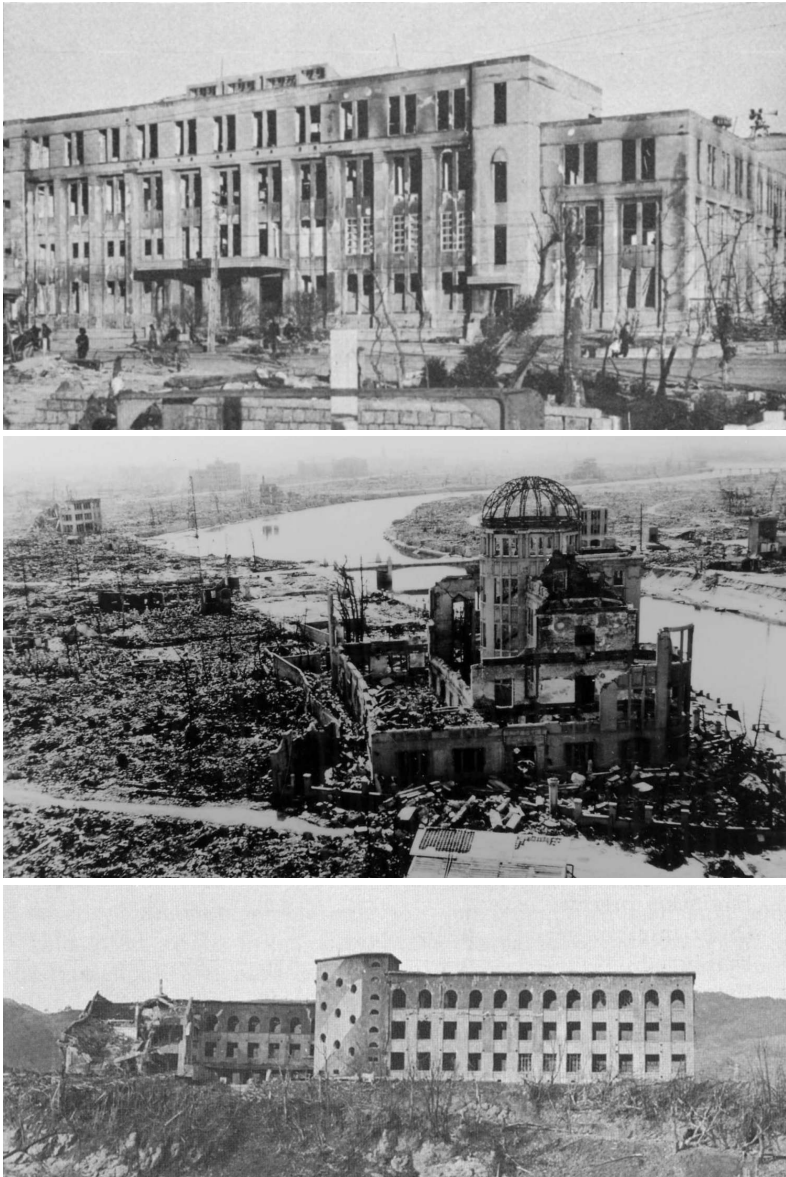
Abbildung 5.3 Drei von vielen ausgebrannten Gebäuden, welche laut einigen Studien [80, 81] unversehrte und zur Messung der \gamma -Strahlendosis durch Thermolumineszenz geeignete Kacheln oder Ziegelsteine bereitstellten. Oben: Rathaus von Hiroshima; Mitte: Halle zur Förderung der Industrie in der Präfektur Hiroshima (heute allgemein “Atomdom” genannt); unten: Shiroyama-Grundschule in Nagasaki.
