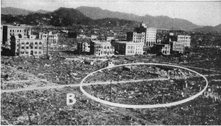
Abbildung 13.1 Foto der Innenstadt von Hiroshima, aufgenommen von Alexander P. de Seversky während seines Besuchs Anfang September 1945. Die ursprüngliche Bildunterschrift [5] lautet wie folgt: “Eine Ansammlung von Bürogebäuden aus Beton, die aufrecht und strukturell intakt inmitten der Asche der umliegenden Holzhäuser stehen, in der Nähe von ‘Ground Zero’ (B).”
